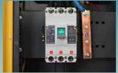
3P Output Breaker Switch
